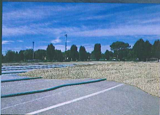
POSA GHIAIA E TUBAZIONI
